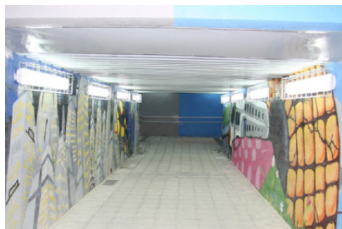
REMODELACIÓN PASO SUBTERRÁNEO Bº ESTACIÓN (FINANCIACIÓN: AYTO. HUMANES DE MADRID)
