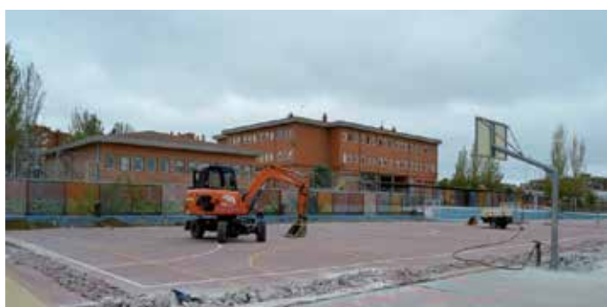
En marcha las obras de instalación de una cubierta en las pistas de fútbol sala del Colegio Público "Campohermoso"
