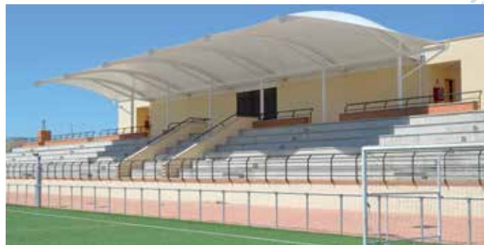
Instalación de una cubierta en la grada del campo de fútbol del Complejo Deportivo Municipal "Vicente Temprado"
